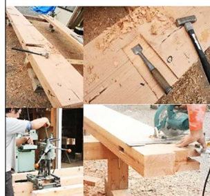
大工の工程③ 刻み
